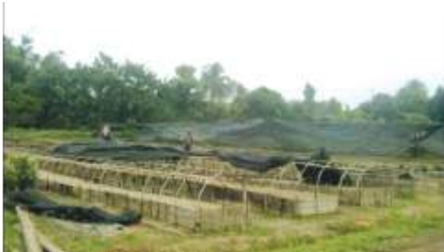
ภาพที่ 18 มุงหลังคา กระบะทราย
