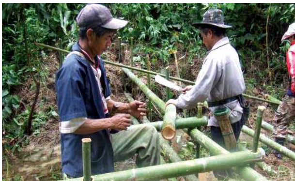
ภาพที่ 35 การวางไม้คาน
