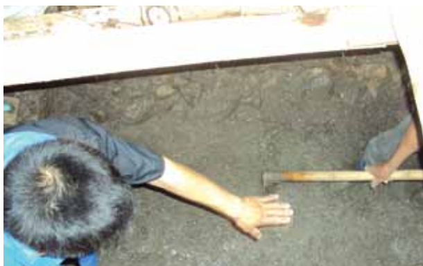
ภาพที่ 114 การเทปูน ลงในร่องแกนและ ปรับหน้าให้เรียบ เสมอกัน
