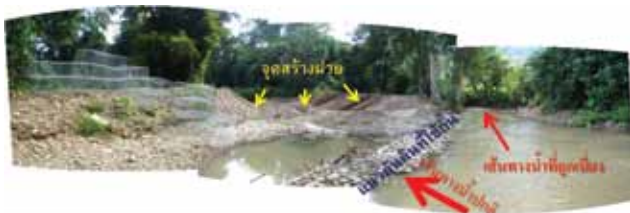
ภาพที่ 56 การเบี่ยงน้ำ โดยชุดร่อง ทำแนวเบี่ยง
