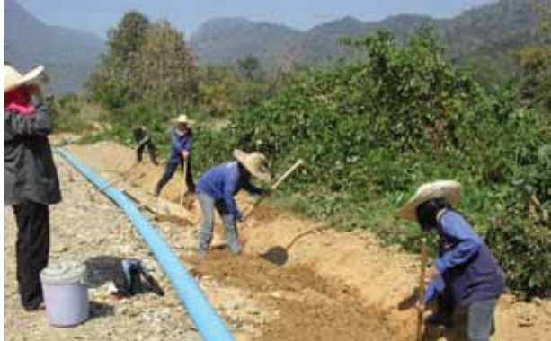
ภาพที่ 136 การขุดเปิดแนวดิน
