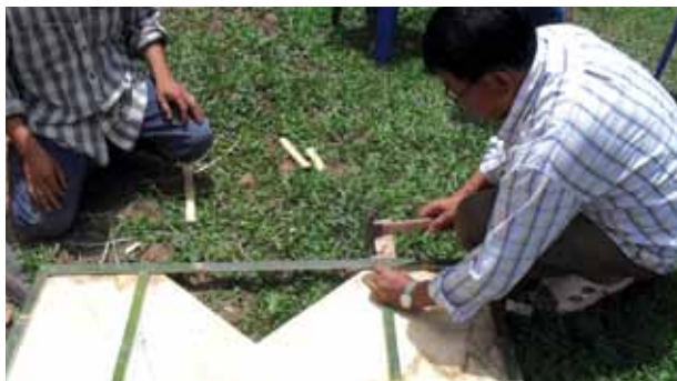
ภาพที่ 15 การเสริมไม้ไผ่ และตะปูที่หัว
