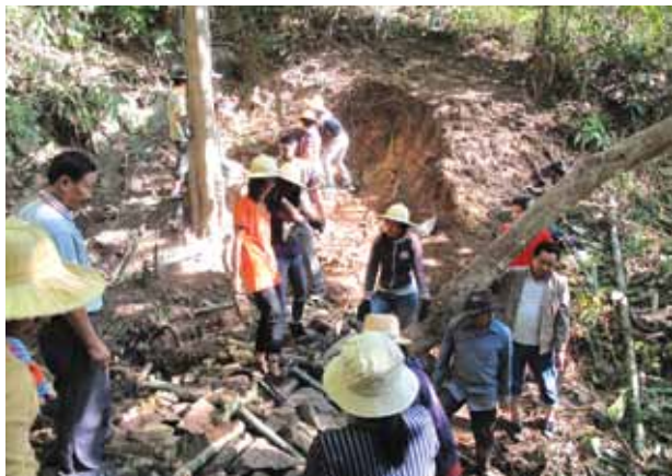
ภาพที่ 45 ชุตดินสำหรับถม จากบริเวณที่สูงกว่า สันฝายไม่น้อยกว่า 1 เมตร
