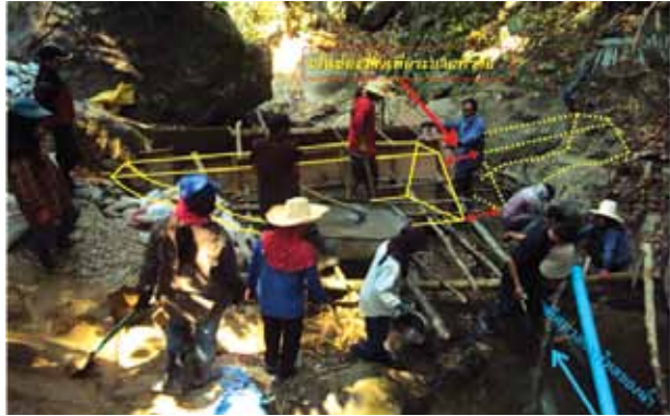
ภาพที่ 57 การเบี่ยงน้ำ โดยสร้างทำนบกั้น
