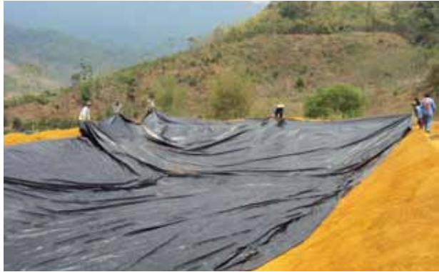
ภาพที่ 160 การคลี่ผ้าพลาสติก ออกให้เต็มบ่อ
