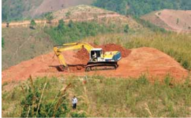
ภาพที่ 154 การใช้เครื่องจักร ขุดบ่อ
