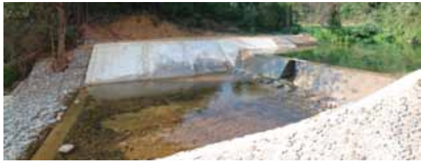
ภาพที่ 113 ฝายหินก่อที่เสร็จ เรียบร้อยแล้วพร้อมใช้งาน
