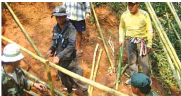
ภาพที่ 34 การพันลวด ยึดไม้เสาหลัก
