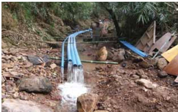
ภาพที่ 55 การเบี่ยงน้ำ โดยใช้ท่อ
