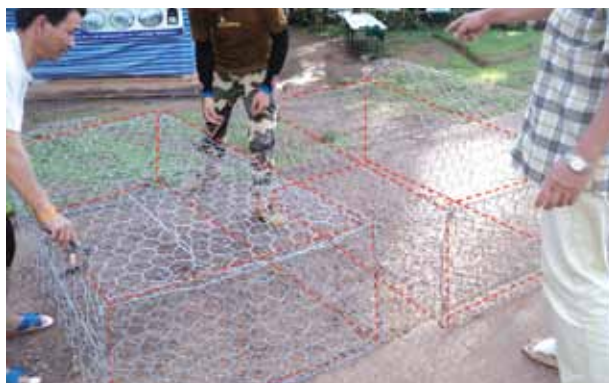
ภาพที่ 71 การนำล่องเกเบียน มาวางเรียงต่อกัน
