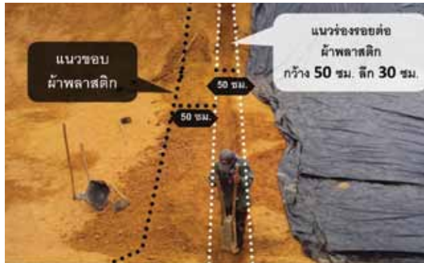
ภาพที่ 164 การขุดแนวร่อง สำหรับต่อผ้าพลาสติก
