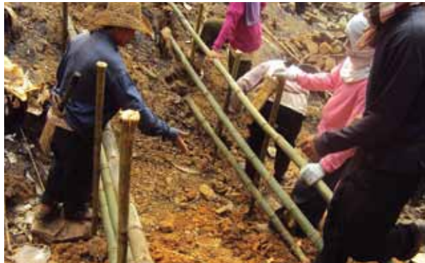
ภาพที่ 32 การปักไม้เสาหลัก
