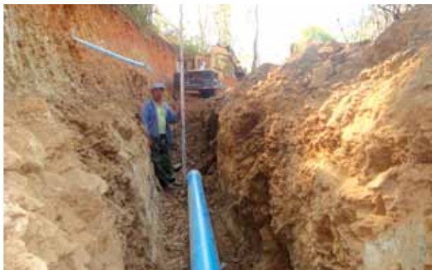
ภาพที่ 137 ความลึกของแนว ท่อควรไม่น้อยกว่า 50 เซนติเมตร
