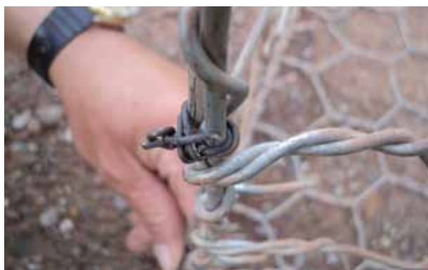
ภาพที่ 67 การมัดซ้ำด้วยลวดดำ เพื่อขึ้นรูปกล่อง และ เสริมความแข็งแรง
