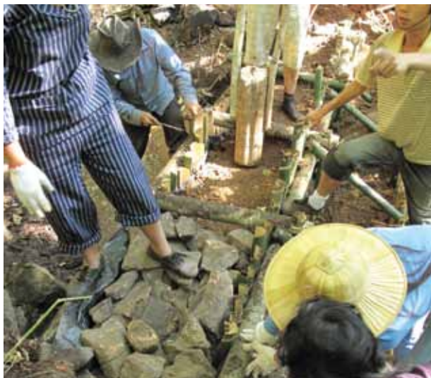
ภาพที่ 49 การวางหิน ทับลงบนหน้าดิน
