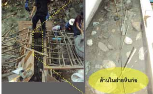
ภาพที่ 116-117 การวางหินทิ้งไว้ ที่ชั้นหน้าปูน เมื่อต้องหยุดพัก ในระหว่างเทปูน
