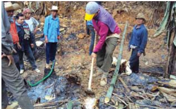
ภาพที่ 29 การขุดร่อง สำหรับวาง ไม้เคร่า
