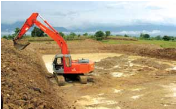
ภาพที่ 146 การปรับ พื้นที่ก่อสร้าง
