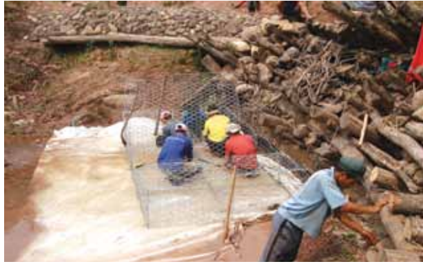
ภาพที่ 93 บุกกลองเกเบียน ลงบนผ้าใบสังเคราะห์ ที่ปูในร่องแกน
