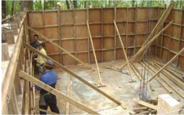
ภาพที่ 151 การดำขันธ์ไม้แบบ จากด้านในถึง
