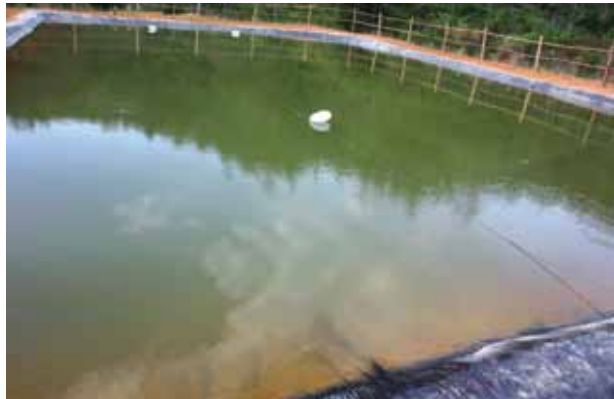
ภาพที่ 173 เชือกที่ชิงไว้ในบ่อพวง เพื่อให้คนที่ตกลงไป มีที่ยึดจับ
