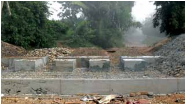
ภาพที่ 108 ฝายเกเบี่ยน ที่เทคอนกรีตแล้ว บางส่วน
