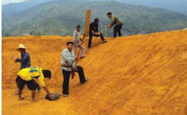
ภาพที่ 156 การปรับพื้น ด้านข้างบ่อ
