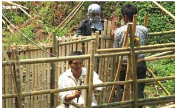
ภาพที่ 33 การตอกตะปู ยึดไม้เสาหลัก
