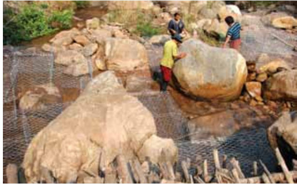
ภาพที่ 97 การวาง กล่องเกเบียน ลงในพื้นที่ ที่มีหินขนาดใหญ่
