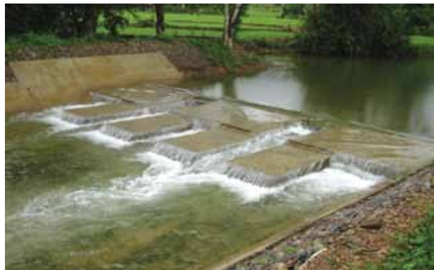
ภาพที่ 112 ฝายเกเบี่ยน ที่สร้างเสร็จแล้ว
