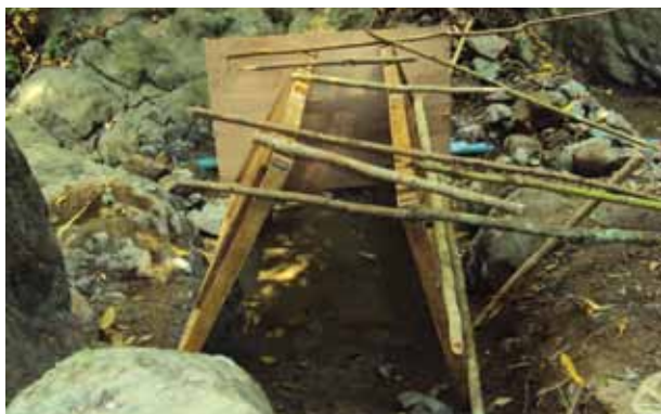
ภาพที่ 115 การตั้งแบบฝายหินก่อ
