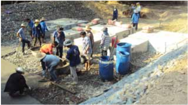
ภาพที่ 109 ฝายเกเบี่ยน ที่เทคอนกรีตปิด เรียบร้อยแล้ว
