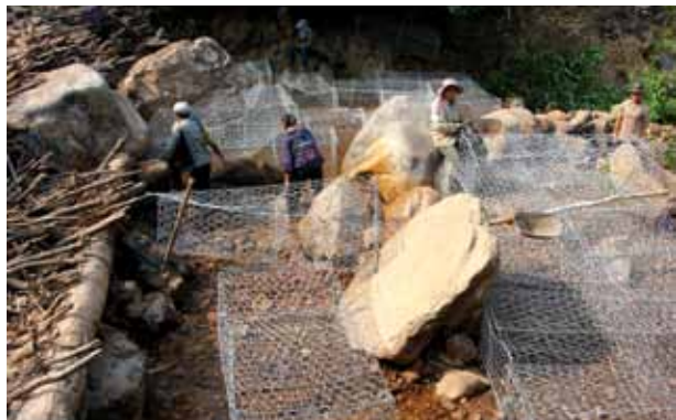
ภาพที่ 99 การวาง กล่องเกเบียน ลงในพื้นที่ ที่มีหินขนาดใหญ่
