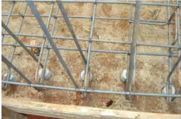
ภาพที่ 149 การตั้งไม้แบบ ด้านในถัง
