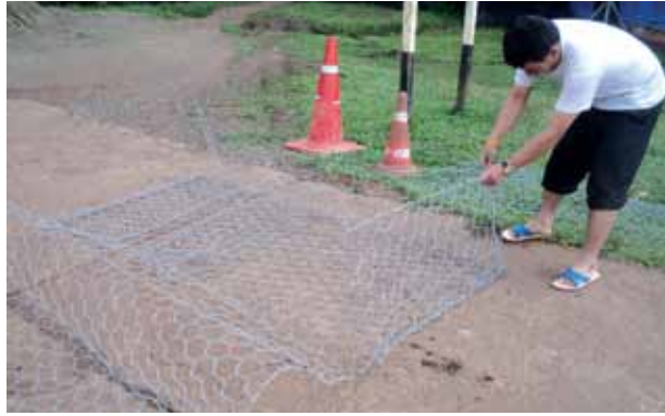
ภาพที่ 64 การตั้งลวด ให้เป็นรูปกล่อง
