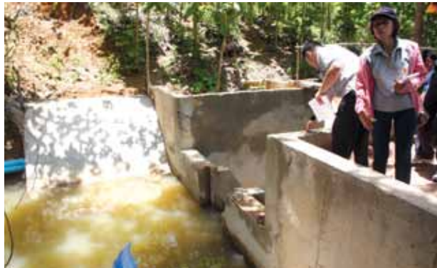
ภาพที่ 121 ฝายคอนกรีต เสริมเหล็ก
