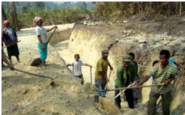
ภาพที่ 139 การทำคันคลอง ไปพร้อมๆ กับ ขุดแนวคลอง
