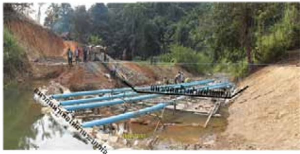
ภาพที่ 54 การเบี่ยงน้ำ โดยใช้ท่อ
