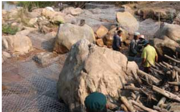
ภาพที่ 98 การวาง กล่องเกเบียน ลงในพื้นที่ ที่มีหินขนาดใหญ่
