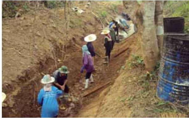
ภาพที่ 141 การเว้นระยะห่าง ระหว่างแบบ สำหรับเทคอนกรีต
