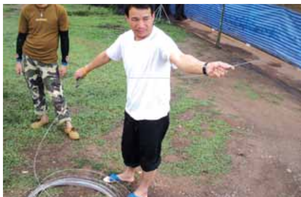
ภาพที่ 72 การตัดลวด ผูกเกเบียน เบอร์ 12
