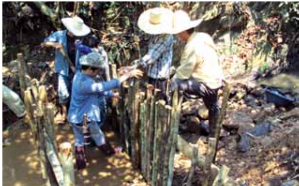
ภาพที่ 41 การใช้ไม้เต็มลำ แทนไม้ซิก
