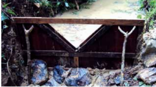
ภาพที่ 20 ปิดช่องว่าง รอบๆ รั้วหนอ มิให้น้ำไหลผ่านได้
