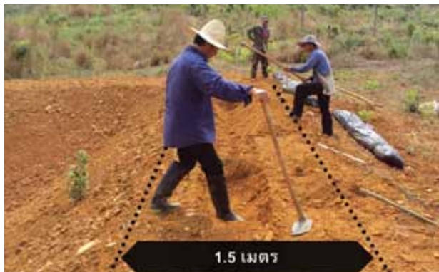
ภาพที่ 157 การปรับดินขอบบ่อ
