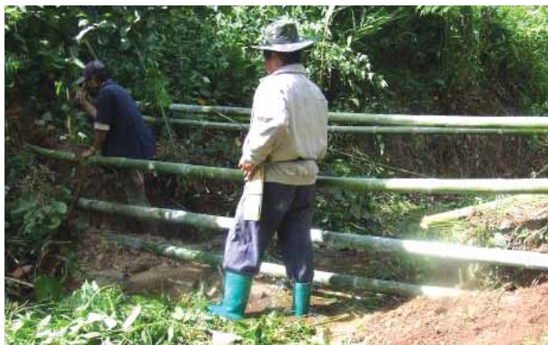
ภาพที่ 30 การวางไม้เคร่า โดยเว้นระยะห่าง ระหว่างแต่ละลำ 1 เมตร
