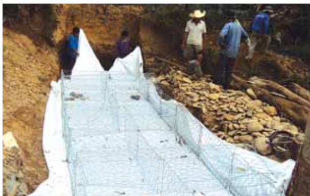
ภาพที่ 92 ผูกผ้าใยสังเคราะห์ กับกล่องเกเบี้ยนก่อน แล้วจึงวางลงไป ในร่องแกน
