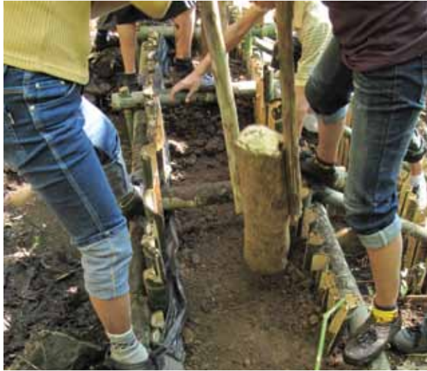
ภาพที่ 48 เว้นระยะประมาณ 20-30 เซนติเมตร จากหน้าดินถึงสันฝาย สำหรับวางหิน
