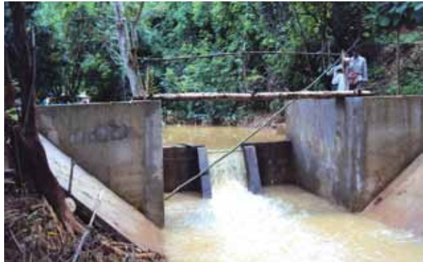
ภาพที่ 120 ฝายคอนกรีต เสริมเหล็ก
