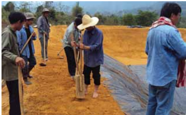
ภาพที่ 163 การอัดดินให้แน่น เพื่อไม่ให้ผ้าหลุด ออกจากขอบบ่อ
