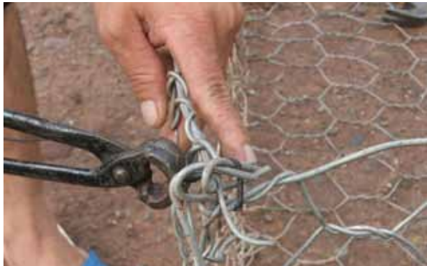
ภาพที่ 65 การใช้คีมผูกเหล็ก มัดขอบกล่องगेเบี่ยน
