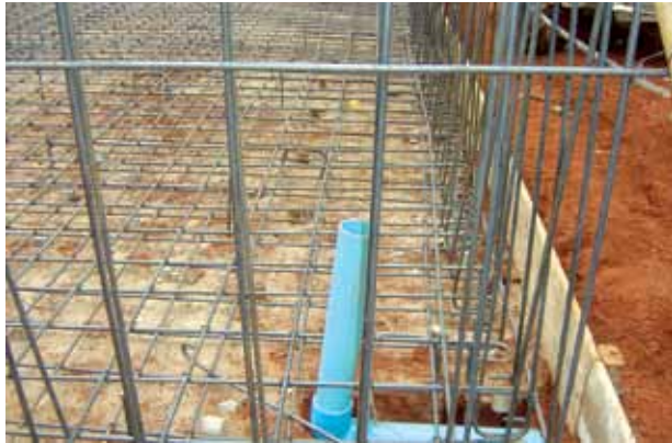
ภาพที่ 147 การวางลูกปูน เหล็กแบบ และท่อ ระบายตะกอน
