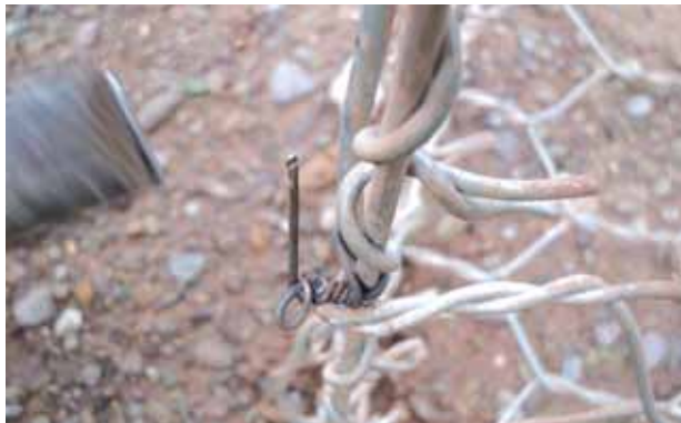
ภาพที่ 70 การมัดซ้ด้วยลวดดำ เพื่อขึ้นรูปกล่อง และ เสริมความแข็งแรง
