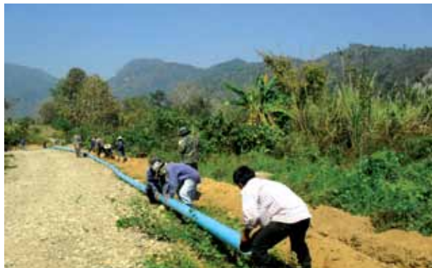
ภาพที่ 135 การวางท่อ เตรียมไว้ ใกล้ๆ แนวท่อ ที่กำหนดไว้
