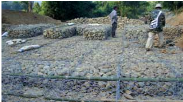
ภาพที่ 107 ฝายเกเบี้ยน ก่อนเทคอนกรีต
