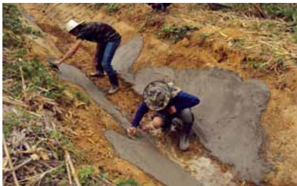
ภาพที่ 142 การเทคอนกรีต ลงในคลอง
