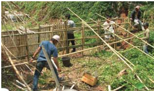
ภาพที่ 37 การวางไม้ค้ำยัน
