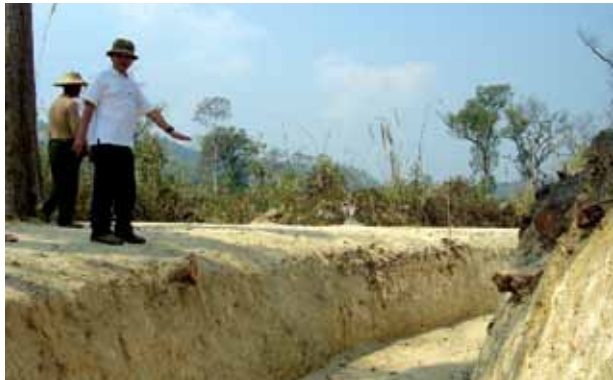
ภาพที่ 140 การปรับดิน ก่อนเทคอนกรีต
