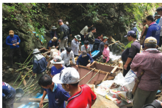
ชาวบ้านร่วมกันสร้างฝายและระบบส่งน้ำเพื่อการอุปโภคบริโภค
