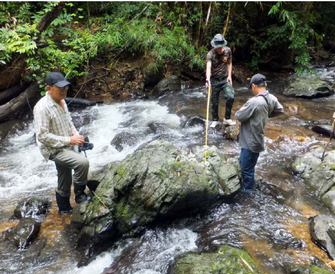
ภาพที่ 6 ฝายบ้านน้ำช้าง โครงการปลูกป่า สร้างคน บนวิถีพอเพียง รักษาต้นน้ำ บรรเทาอุทกภัย จังหวัดน่าน
